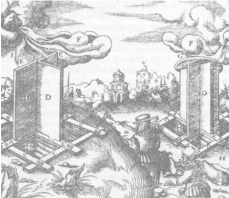
Figura 5.1. Paneles de dirección para los túneles de ventilación. Tomado de G. Agrícola, De rerum metallica, Basilea 1556. (Por cortesía de la British Library.)
